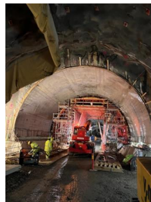
Mälarpassagen, gjutning av avjämningsbetong
