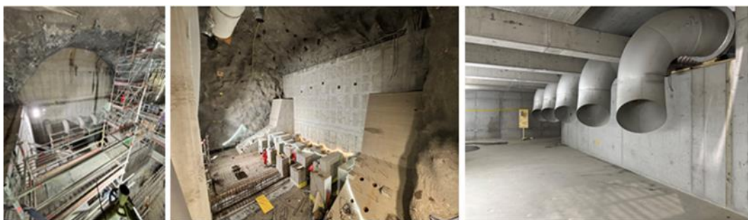
Sickla januari 2026. Från vänster till höger: Bromma PST pumpgröp / pumpsal / utloppsör i grovreningen
